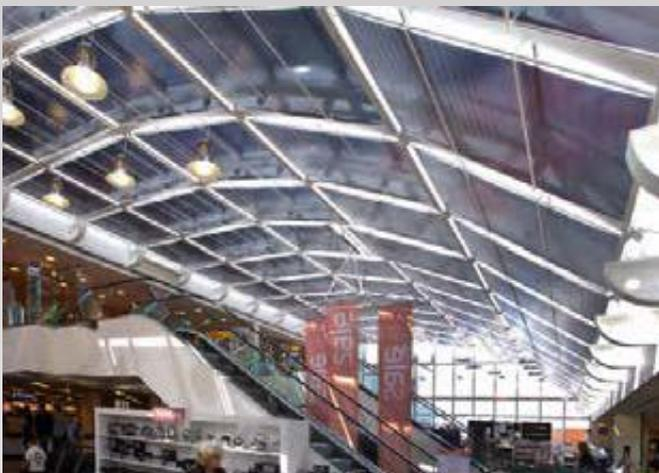
Im Karstadt Warenhaus Stuttgart sorgen großzügige Glasfronten und ein gläsernes Kuppeldach für lichtdurchflutete Verkaufsräume. Im Zuge einer Sanierung wurde das Glasdach vollständig erneuert und die bisherige Außenverschattung durch innen liegende Sonnenschutzsysteme von MULTIFILM® ersetzt.
